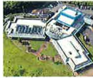
施設全体 （令和5年3月末 改修完了）
